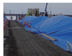
打設前の路面熱養生
