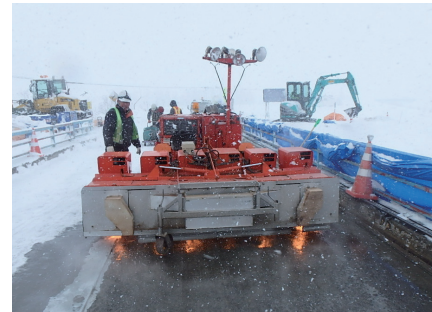
打設前の路面熱養生
