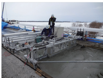
J-ティフコム打設状況
