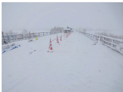
施工前現場状況
