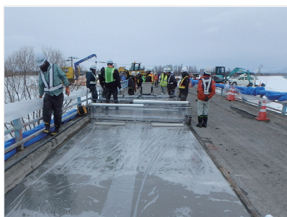
打設後のシート養生
