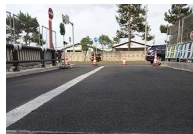
すべり止め舗装完了
