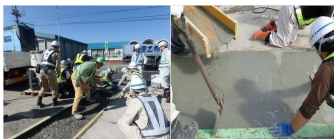
超早強硬化型によりミキサーから直接打設
