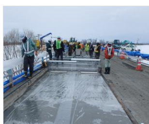
打設後のシート養生
