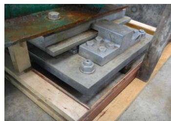
型枠設置状況
