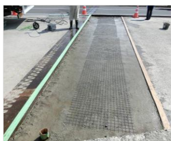
損傷範囲により補修幅を変更
