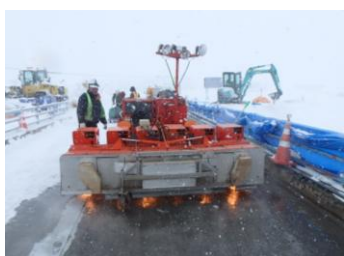
打設前の路面熱養生
