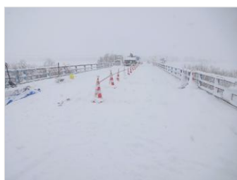
施工前現場状況
