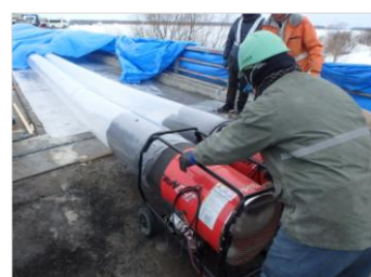
防寒養生(給熱養生)
