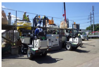
現場練り混ぜ状況
