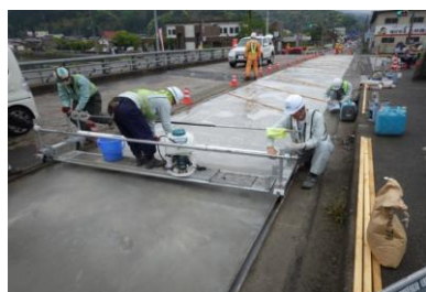
連続打設とシート養生
