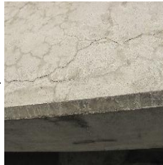
外面プロテクト施工例(海岸)
